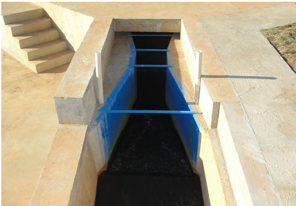
FOTO ILUSTRATIVA DO MEDIDOR DE VAZÃO TIPO CALHA PARSHALL
